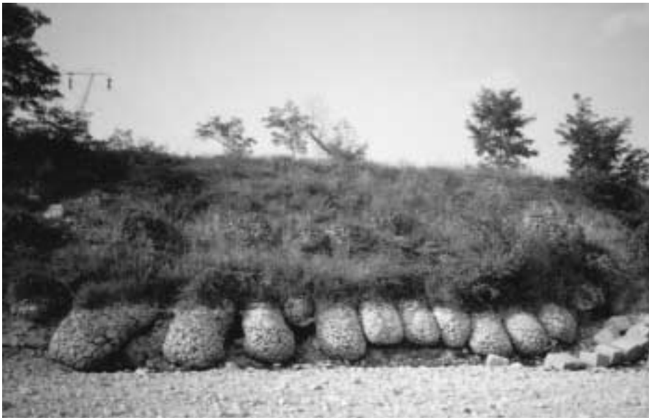
I gabbioni che servivano a proteggere la sponda dall'erosione che erano stati realizzati a partire dal piano di campagna fino al livello del fiume. Ora sono scesi parallelamente all'abbassarsi del fondo dell'Orba, quindi il fiume era meno profondo in passato, presentava più ghiaia.
