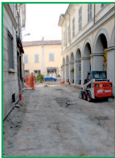
I lavori in via XXV Aprile
