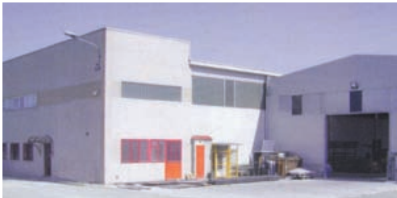
Nella foto in alto: l'ingresso degli uffici e dello stabilimento; a lato: Antonio Aita, fondatore ed attuale presidente della CFA srl
