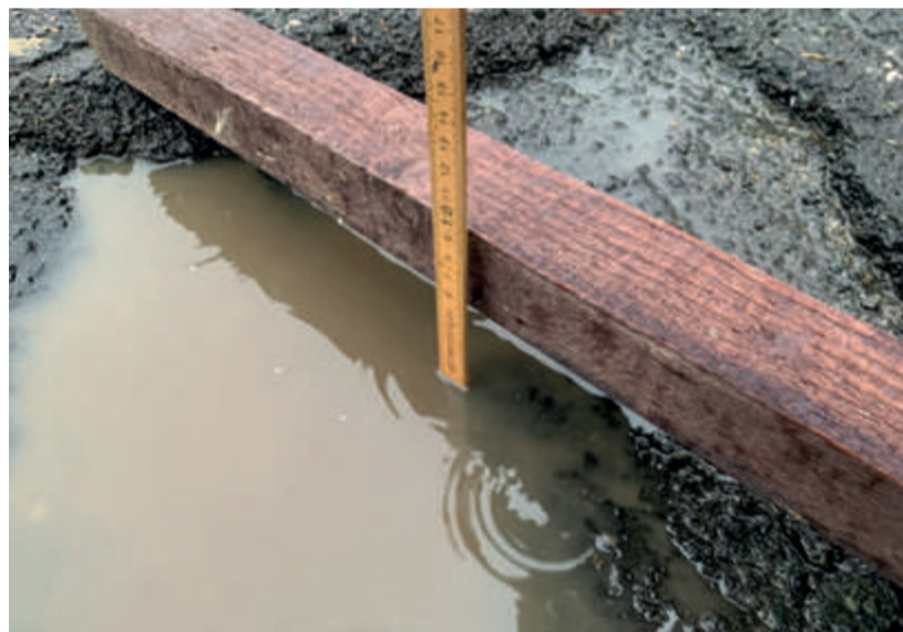
Una delle foto inviate dal Sindaco alla Provincia dove si evidenzia la profondità delle buche.
