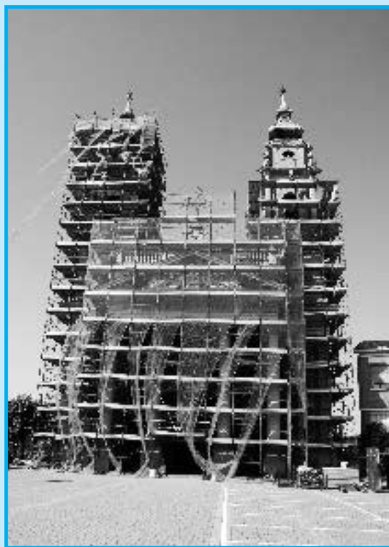
I lavori in corso
