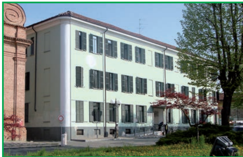
Sopra: la facciata con l'ingresso della Casa di Riposo San Carlo. Nella pagina a fianco: in alto la palestra; sotto il corridoio di accesso all'interno della struttura.
